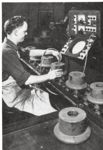
Das „Reflectoscope“ in Aktion. Das „Reflectoscope“ sendet Ultraschallwellen durch die Gussteile. Materialdefekte werden im Oszilloskop durch Signalspitzen (D, unten links) angezeigt. Ist das Gussteil in Ordnung, ist das Signal ungestört (oben rechts). Klemm, A. (1947). Instrumentation, Measurement, and Control. Scientific American , 176 (3), 122-128. Bildrechte sind dem S. A. nicht bekannt.
